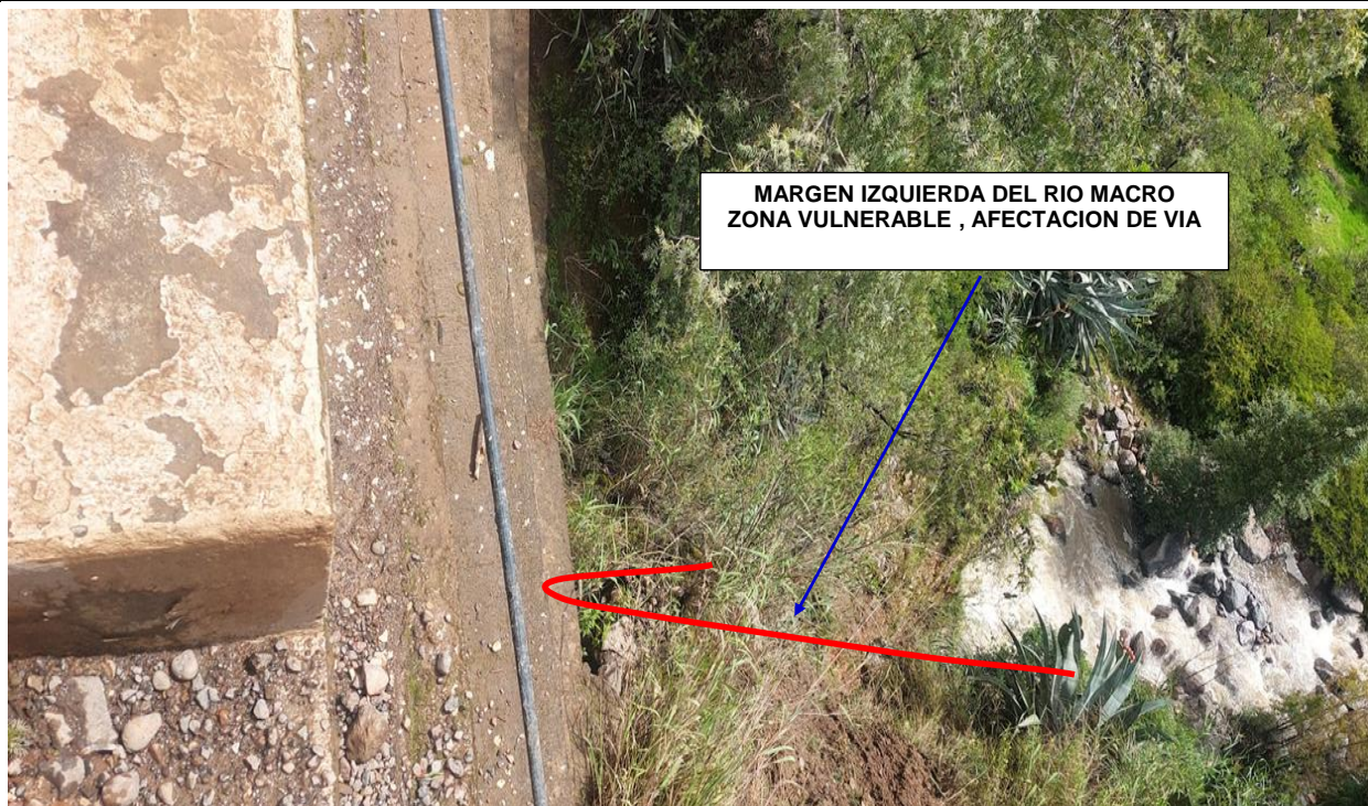
FIGURA N° 01: TRAMO CRÍTICO EN EL RIO MACRO, INICIO DE TRAMO DE INTERES, CON AFECTACION A LA TALUD DE LA VIA NACIONAL AYACUCHO-CANGALLO L=140M
