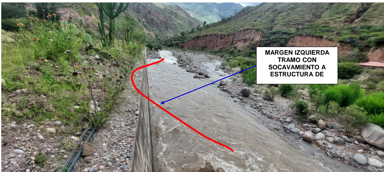
FIGURA N°04: EN LA TEMPORADA DE MAXIMAS AVENIDAS, EL RIO MACRO GENERA SOCAVACION EL LADO IZQUIERDA A LAS ESTRUCTURA DE PROTECCION.
