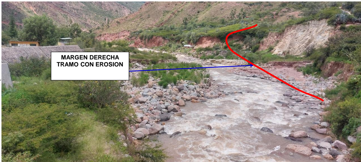
FIGURA N°03: EN LA TEMPORADA DE MAXIMAS AVENIDAS, EL RIO MACRO EROSIONA EL LADO DERECHO PUESTO QUE NO CUENTA CON ESTRUCTURA DE PROTECCION.
